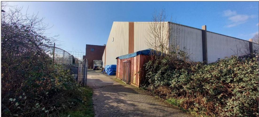
Plangebied; loods van damwandprofiel met dakleer niet geschikt voor verblijfplaatsen vleermuizen. Foto F.V. van der Lans | Ecoresult BV
